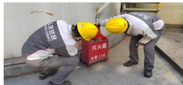
灭火器安全隐患排查
