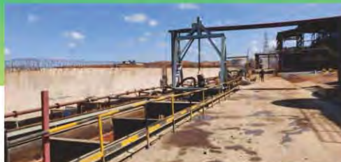
图：五级沉淀池
